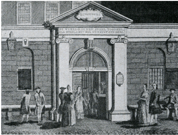
Gezicht van de Voorpoort of Ingang van den Schouwburg te Amsterdam op de Keysergragt, A. 1772. Vue du portail de l'ancienne Comédie d'Amsterdam, du côté du canal Imperial, A. 1772.
