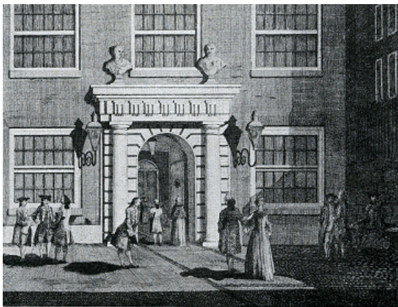
Gezicht van het Voorplein en de Binnenoort van den Schouwburg te Amsterdam, A. 1772. Vue de la cour & de la Seconde porte de l'ancienne Comédie d'Amsterdam, A. 1772.
